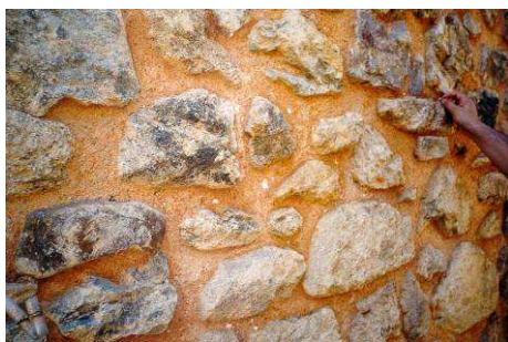
Fig. 14 – a) Argamassa com agregado argiloso de forte poder colorante para simular b) argamassa original de terra (Castelo Rodrigo)
