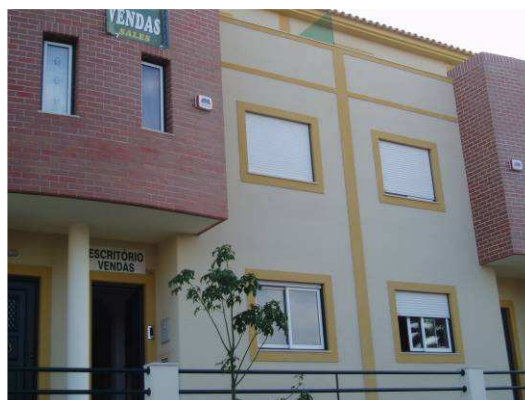
Fig. 19 – Revestimentos de argamassa colorida na massa (monocamada)
