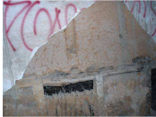
Fig. 11 – Argamassa de terra com fibras vegetais em Vinhais (Casa dos Condes)
