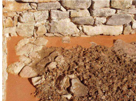
Fig 2 - Argamassa de restauro utilizada no Rabaçal
