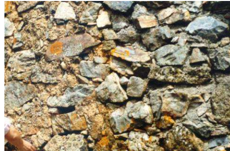
Fig. 14 – a) Argamassa com agregado argiloso de forte poder colorante para simular b) argamassa original de terra (Castelo Rodrigo)
